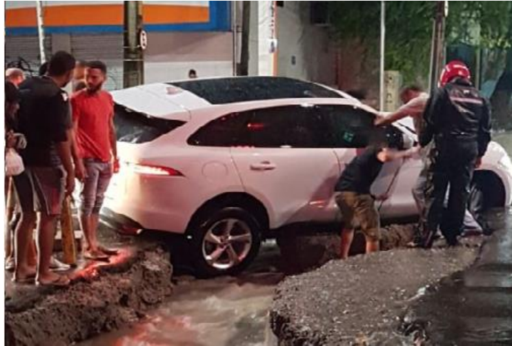
Figura 1: Problemática urbana causa pelas chuvas em Fortaleza/CE.
