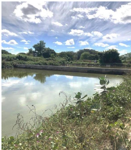
Figura 2. Estação de tratamento de esgoto de São Fernando/RN, composta por lagoas de estabilização.
